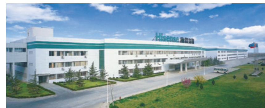
Hisense (Shandong) Air Conditioner Ltd., г. Циндао
