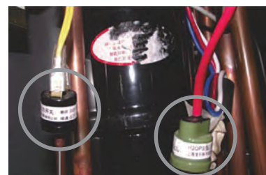
Выключатель низкого давления
