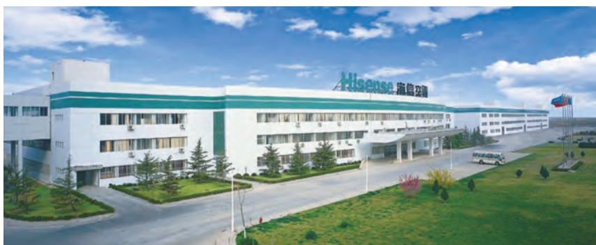
Hisense (Shandong) Air Conditioner Ltd., г. Циндао
