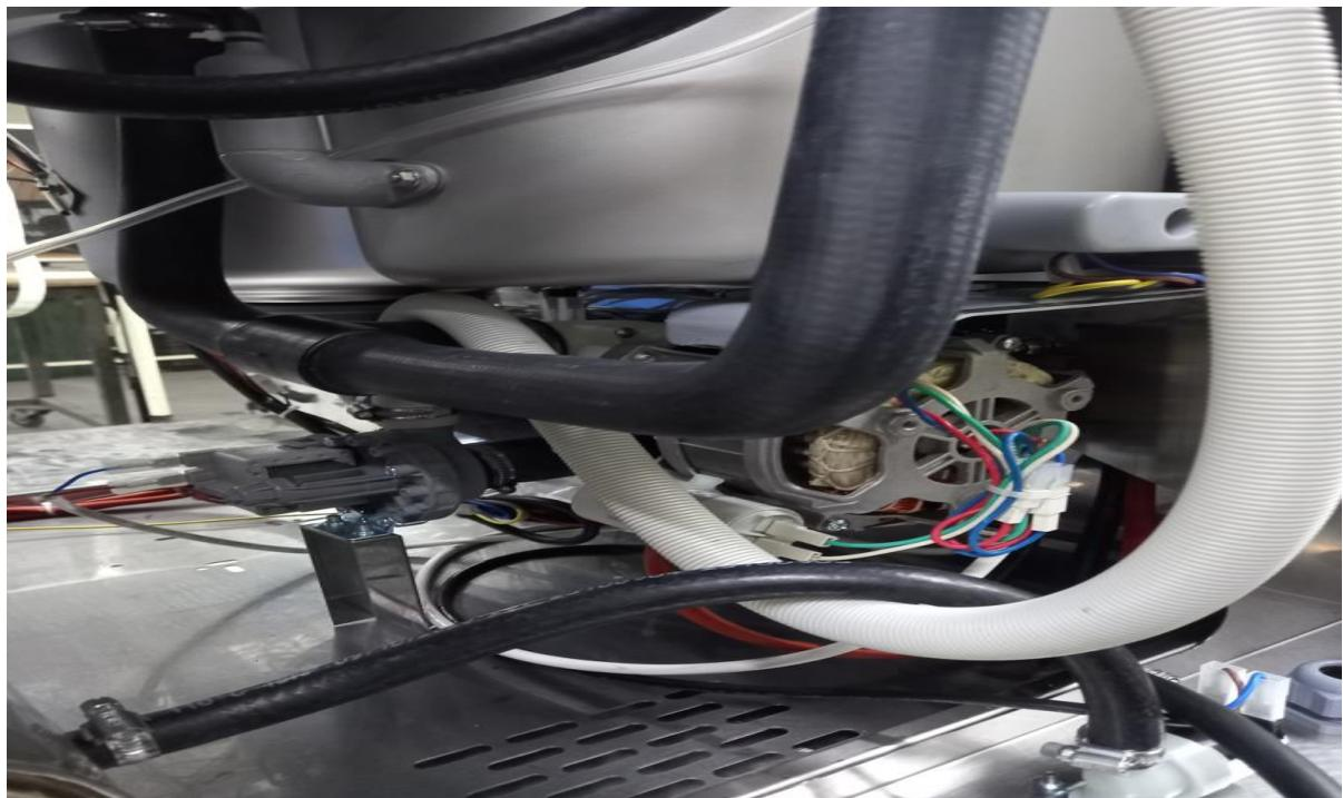
После установки сливного насоса сливной шланг размещается так, чтобы он оставался внутри изделия. Таким образом закрывается задняя панель и упаковывается. После доставки товара покупателю техническая служба осуществляет соединение слива воды и сливного шланга.
