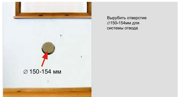
4 МОНТАЖ ЭЛЕМЕНТОВ ОТВОДА ПРОДУКТОВ ГОРЕНИЯ
