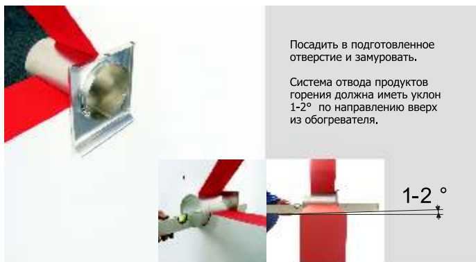
9 МОНТАЖ ЭЛЕМЕНТОВ ОТВОДА ПРОДУКТОВ ГОРЕНИЯ
