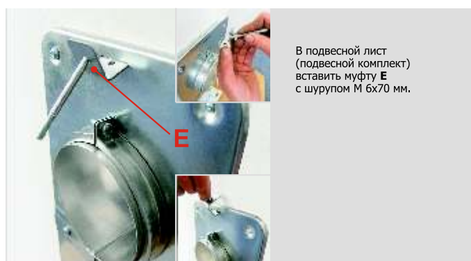
12 МОНТАЖ ЭЛЕМЕНТОВ ОТВОДА ПРОДУКТОВ ГОРЕНИЯ
