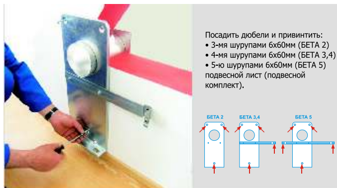
10 МОНТАЖ ЭЛЕМЕНТОВ ОТВОДА ПРОДУКТОВ ГОРЕНИЯ
