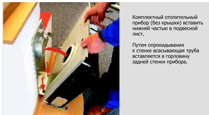
14 МОНТАЖ КАМЕРЫ ГОРЕНИЯ
